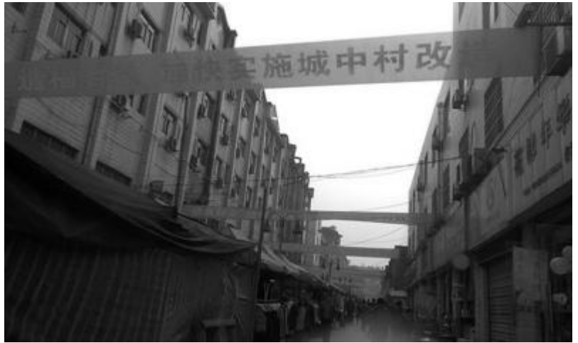
西桃园村拆迁改造中
