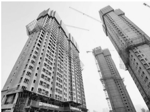
大寨村城中村改造村民安置楼项目1、4号楼顺利封顶
