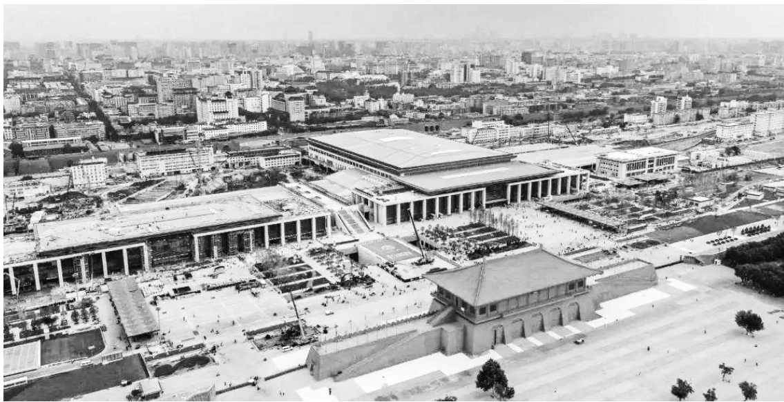
2021年建设中的西安站北站房和北广场
