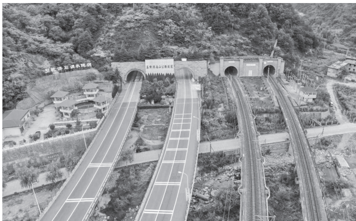
2021年，无人机视角下的秦岭终南山公路隧道和高铁隧道
