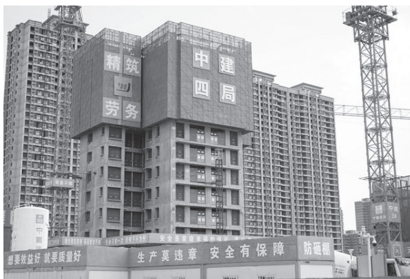
正在建设中的红旗村廉租房项目
