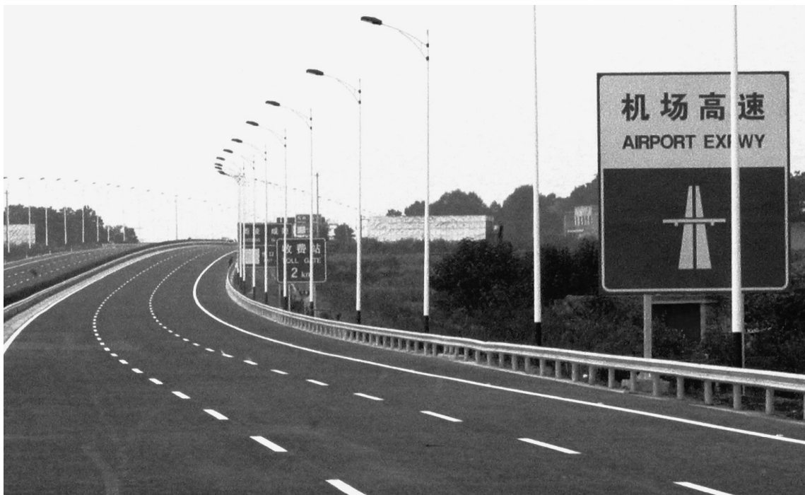
2003年9月，西安咸阳国际机场高速公路建成通车
